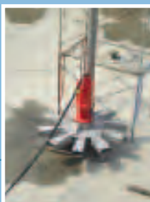
Installation d'un aérateur type SCLK avec tube rigide. Instalación de aireador sumergido modelo SCLK.
